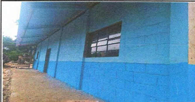
Foto 2: Sustitución de puertas y ventanas.
