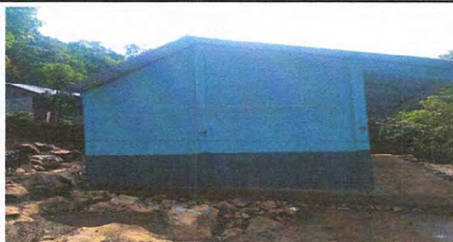
Foto1: Ampliación de aula Multigrado.
